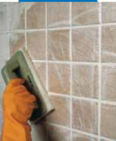
Konečná úprava jedenkrát pálených obkladů houbou Scotch-Brite®
