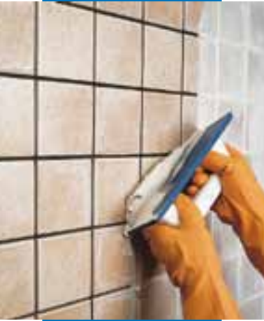
Spárování jedenkrát pálených obkladů gumovou stěrkou
