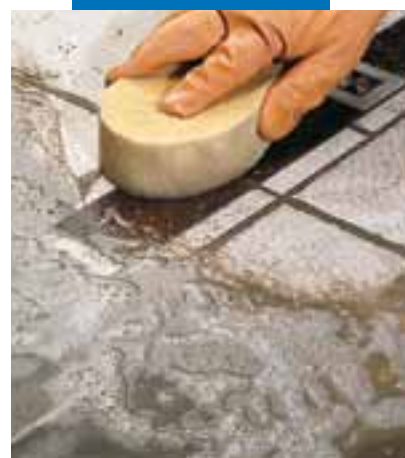
Dočištění keramické dlažby s vloženými dřevěnými prvky houbou
