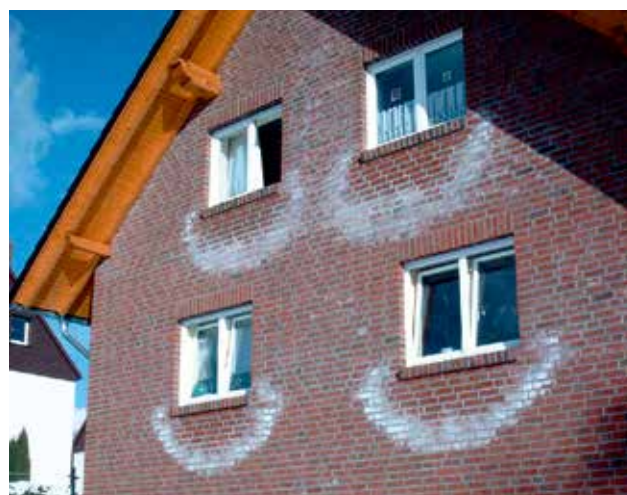
Ausblühungen (hier im Bild die sogenannten „Wassersäcke“), entstanden durch Regenwasser, das durch nicht fachgerecht ausgeführte Fensterbänke in das Mauerwerk eingedrungen ist.
