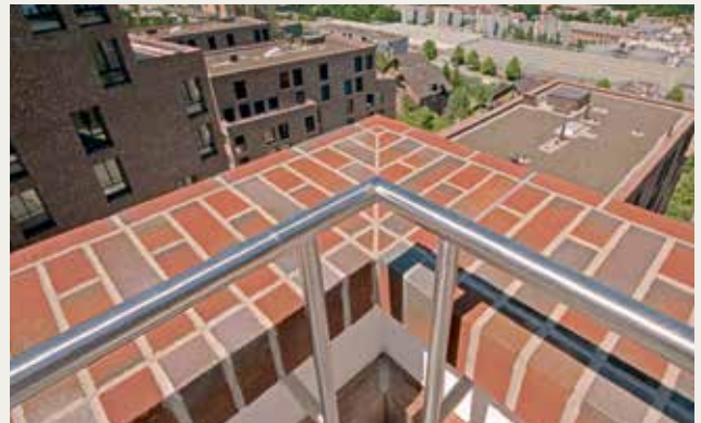
Ein Röben Fertigteil als präzise ausgeführte Mauerwerks-Abdeckung, individuell für das Objekt vom Röben PlanungsService entwickelt und produziert. Hier als Balkon-Brüstung mit drei Sichtseiten.
