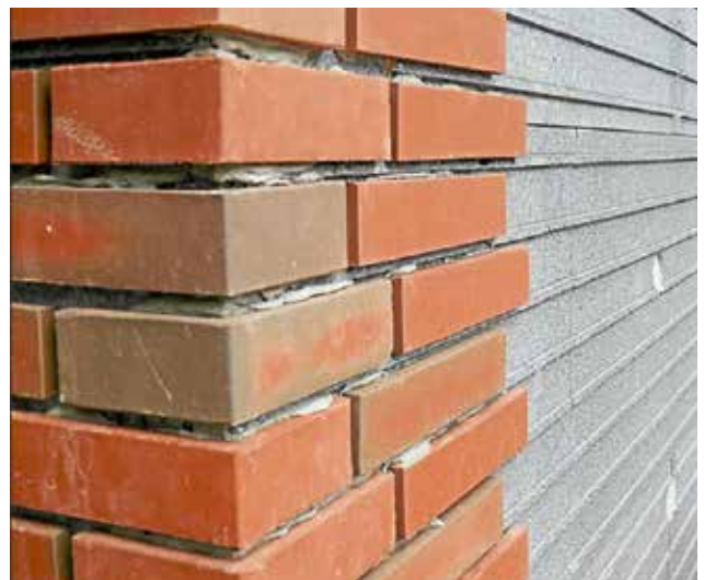
Die hohe Maßhaltigkeit der Röben Klinkerriemchen und der perfekte Winkel der Eckriemchen erleichtern die Montage im Fugenleitsystem
