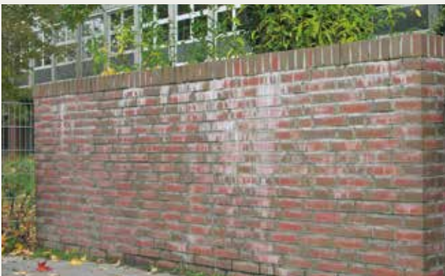
So bitte nicht: Die Oberkante dieser Mauer wurde manuell erstellt. Die Folge: Regenwasser dringt ins Mauerwerk ein und verursacht hässliche Auslaugungen. Mit einer vorgefertigten Mauerwerksabdeckung von Röben wäre das nicht passiert.
