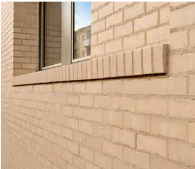
Bündig abgezogene, nicht zusätzlich verdichtete Mörtelfugen.
