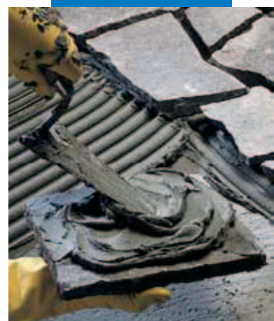
lepení dlažby z lamaného přírodního kamene bez anebo s „podmazáním“
