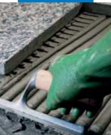
lepení vymývané betonové dlažby v exteriéru
