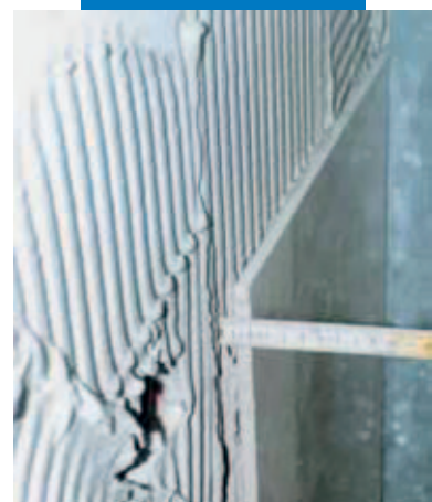
lepení slinutého obkladu stěn do silné vrstvy lepidla
