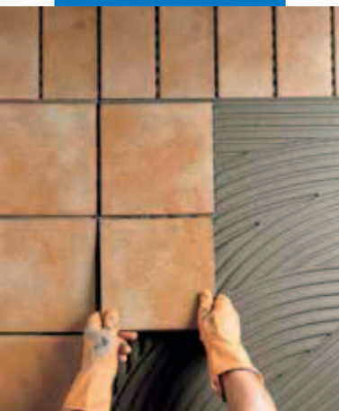
lepení klinkeru v exteriéru
