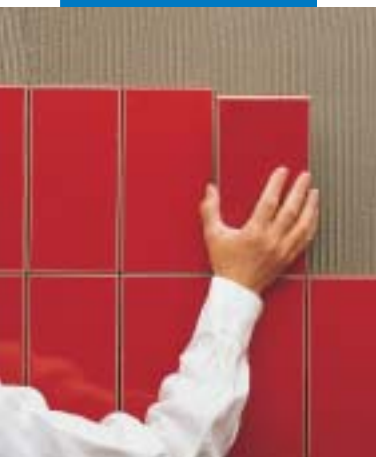
Montáž obkladů na stěnu
