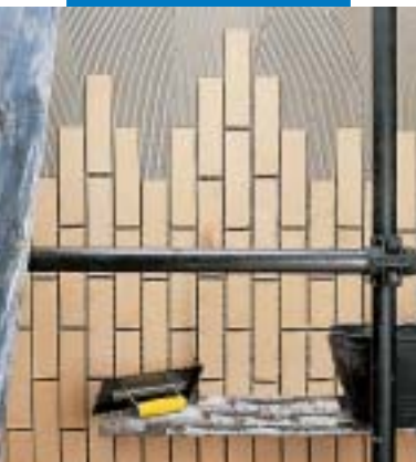
Montáž keramických obkladů stěn v exteriéru
